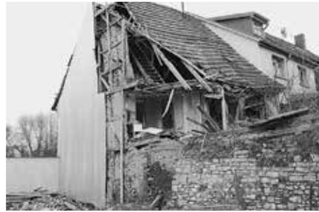
Mit Hilfe von Fachleuten reparierten sie die erhaltenswerte Bausubstanz, wobei auch alte Balken und Ziegel aus Abbruchhäusern Verwendung fanden. Der rückwärtige Teil des Anwesens war aber nicht zu halten und wurde durch einen zierlichen zwei-stöckigen Neubau ersetzt. Quaderförmig ragt er seitlich in den Wohnraum und öffnet sich vollverglast zum Garten auf der Südseite.
