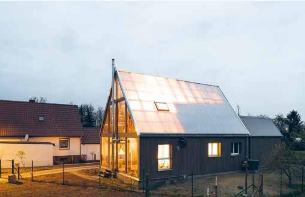
Statt das kleine Ziegelhaus mit dicken Dämmplatten zu bekleben, wählte man hier einen eleganten Weg zum Wärmeschutz: ein Haus um das Haus, das die Sonne einfängt. „Thermohaus“ heißt dieser Umbau plakativ, wobei man gerade nicht an eine Thermosflasche denken sollte, denn die minimiert die Energieverluste.
